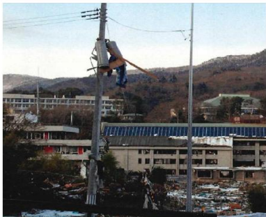
流出した容器が電柱にぶら下がっているのが分かる
