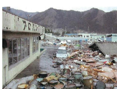
車両も含め、容器が流出したままとなっている
