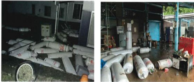
(例) 軒先のガス供給機器に被害があった様子
