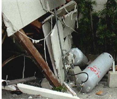
家屋倒壊、容器まで破損かは不明
